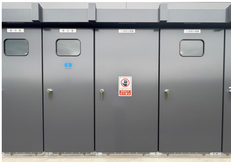
▲ 12 相トランス搭載 直流キュービクル（実証品）
