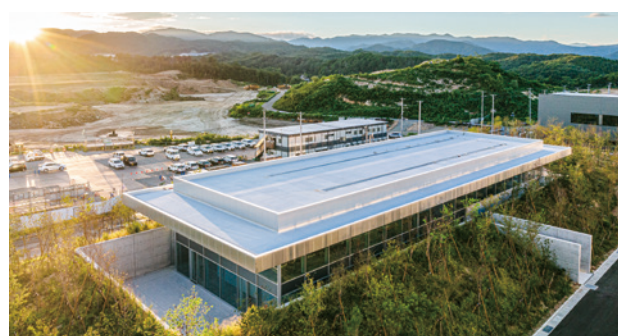
郡山工場厚生棟「AQURIO」
