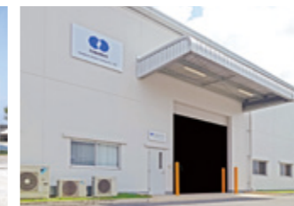
Kawamura Electric Vietnam Co., Ltd. 配電盤の製造、販売
