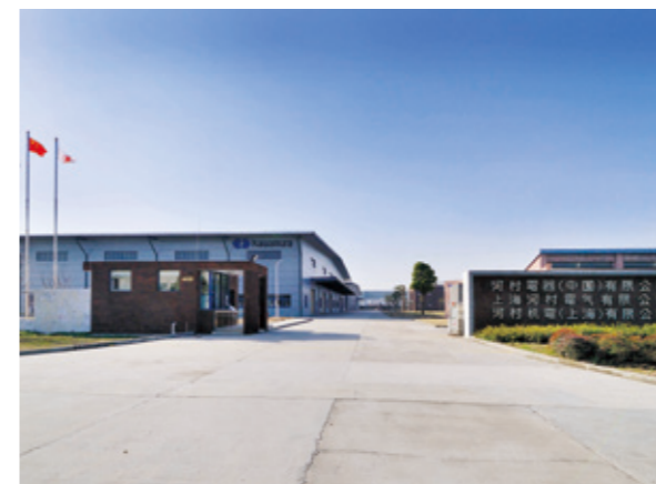
上海河村電気有限公司 高圧・低圧受配電盤の設計、製造、販売
