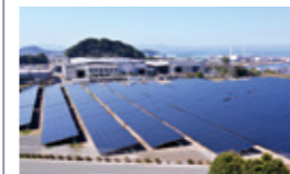
水俣太陽光発電所
