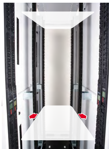
収納・配線スペースが拡大
