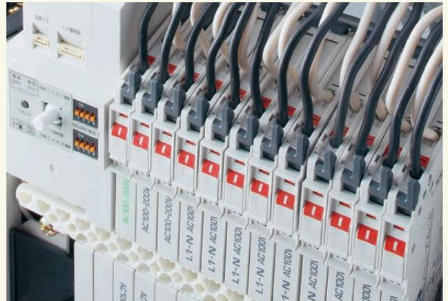
業界最薄のブレーカを搭載した分電盤の内部
