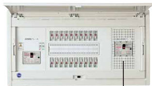
太陽電池側ブレーカ(1次送り) (逆接続可能タイプ)
