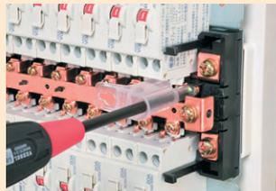
切替部材ごとネジを元に戻し締めます。
