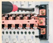
ブレーカ端子ネジを締め付け、200Vに切替え完了です。
