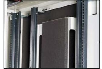
ラック内部に吸音材付のパネルを設置しています。騒音源近くで吸音できるため、騒音対策の効果は◎
