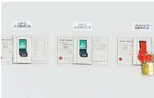
入力側/出力側/バイパス側ブレーカにて構成されたUPSライン用の入出力盤を収納しています。(PFU(V)Tタイプ)
