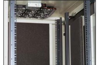
サイドパネルとリア扉に吸音材を使用しています。音を吸収して騒音を減少させます。
