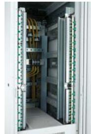
二次側端子台を両脇に設置。上部への配線処理が容易です。(上部配線型)
