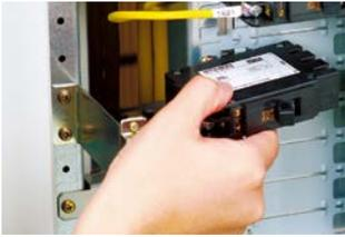
プラグインブレーカの採用により分岐ブレーカの追加変更などの作業時間が短くなります。
