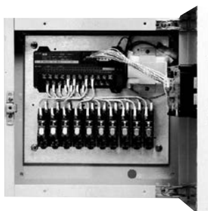
有電圧入力用リレー実装例 (オプション)
