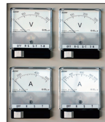
電流計 電圧計 積算電力量計
