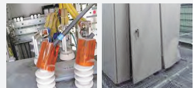
端子台の破損
