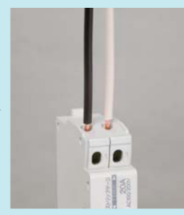
電線を端子に差し込みます
