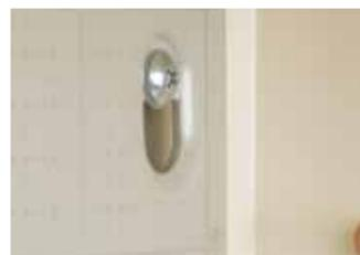
基板取付ネジ FXT: トラス小ネジM5×8
