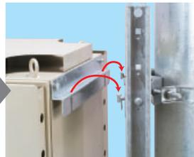
取付金具(上)の四角ボルトに振止金具を引っ掛けて仮固定します。その際、キャビネットを支持金具(左/右)に載せてください。
