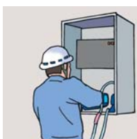
狭いキャビネット内で配線
