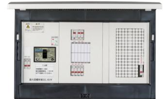
単2 主幹：漏電ブレーカ(ELB2P) 分岐：ノーヒューズブレーカ(MCB2P2E)
