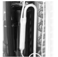
特殊塗装を施した冷媒配管
