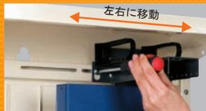
機器を取付けた後も位置調整が可能。標準取付位置から側面ドア側に60(50)mmスライドし、内側には15mm~115(35)mmの間で調整できます。奥行のある機器の設置時に便利です。※( )内数字はN500タイプを示します。
